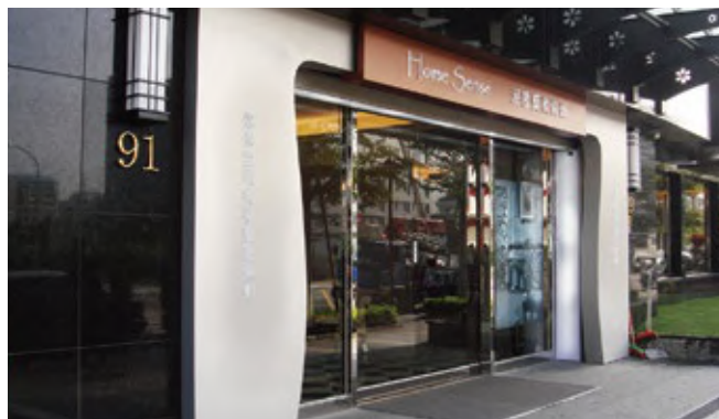
2.金屬造型門框+金屬簍空燈箱+水晶字
