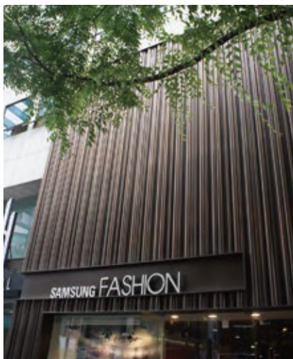
1.金屬底板+H型鋼+精品字
