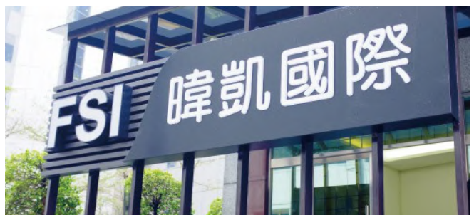
10.金屬格柵+千那論+雷射簍空燈箱+水晶字
