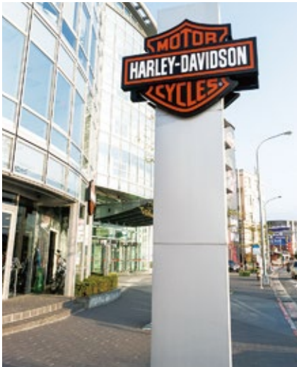
1.金屬立柱+金屬雷射鏤空燈箱
