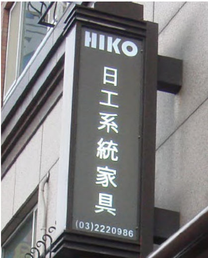
1.金屬造型方管框+壓克力面板
