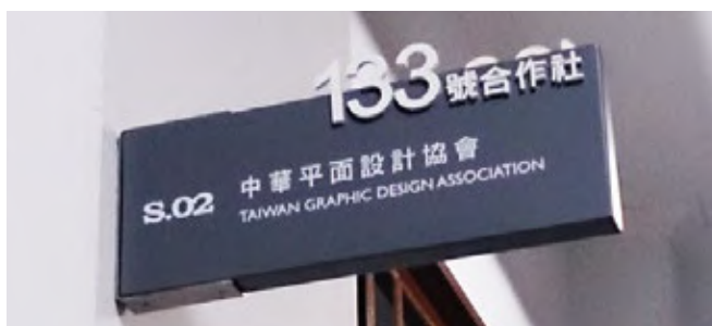
5. 壓克力面貼輸出+壓克力字
