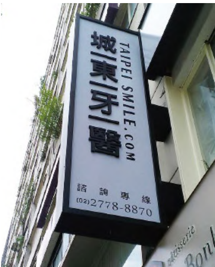
4.金屬方管框燈箱+壓克力立體字
