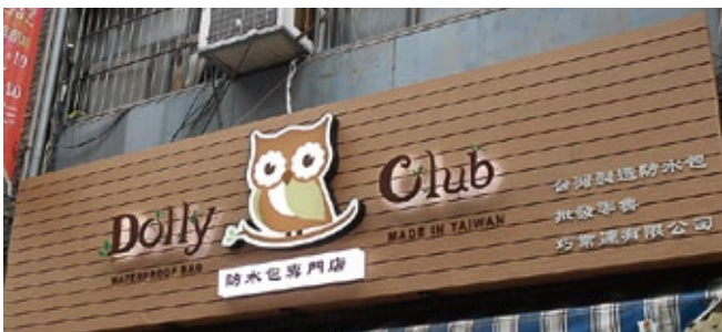
7.企口板+壓克力燈箱+金屬背光字浮腳
